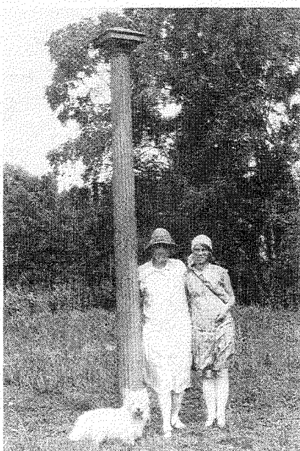
Afbeelding 6. Een situatie in Engeland waar de bodemdaling agv ontwatering en ontginning inzichtelijk is gemaakt door het niveauverschil met 140 jaar geleden, de lengte van de paal..., weer te geven.
