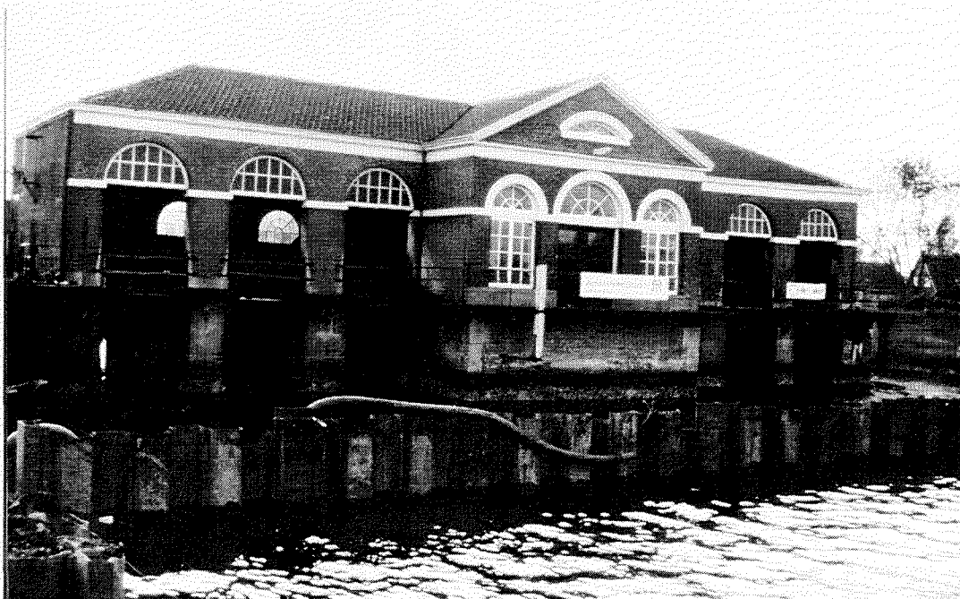
Afbeelding 23. De 6 raderen van stoomgemaal 'Halfweg' zijn ondergebracht in 2 schepradhuizen, aan weerszijden van het machinehuis.
