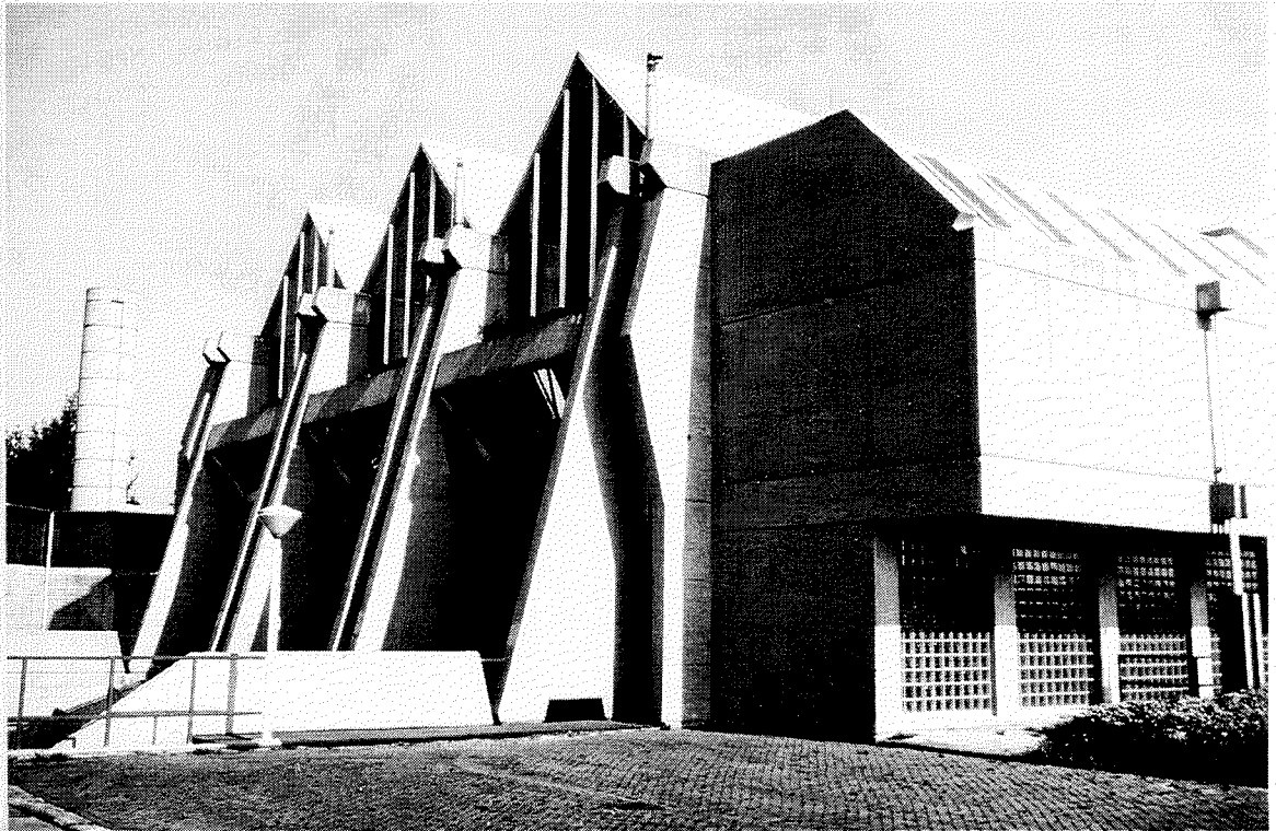
Afbeelding 15. Gemaal 'Halfweg' (boven) en gemaal 'Kadoelen' (onder): voorbeelden van moderne vijzelgemalen.
