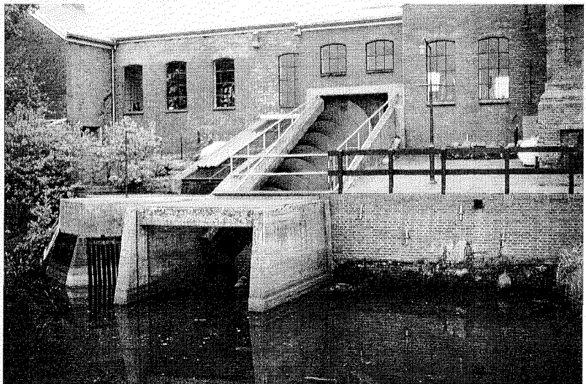
Afbeelding 57. Bij gemaal 'Winschoten' is er sprake van een electrisch én een stoom aangedreven vijzel. Een bijzondere situatie die uit capaciteitsoverwegingen ontstaan is.
