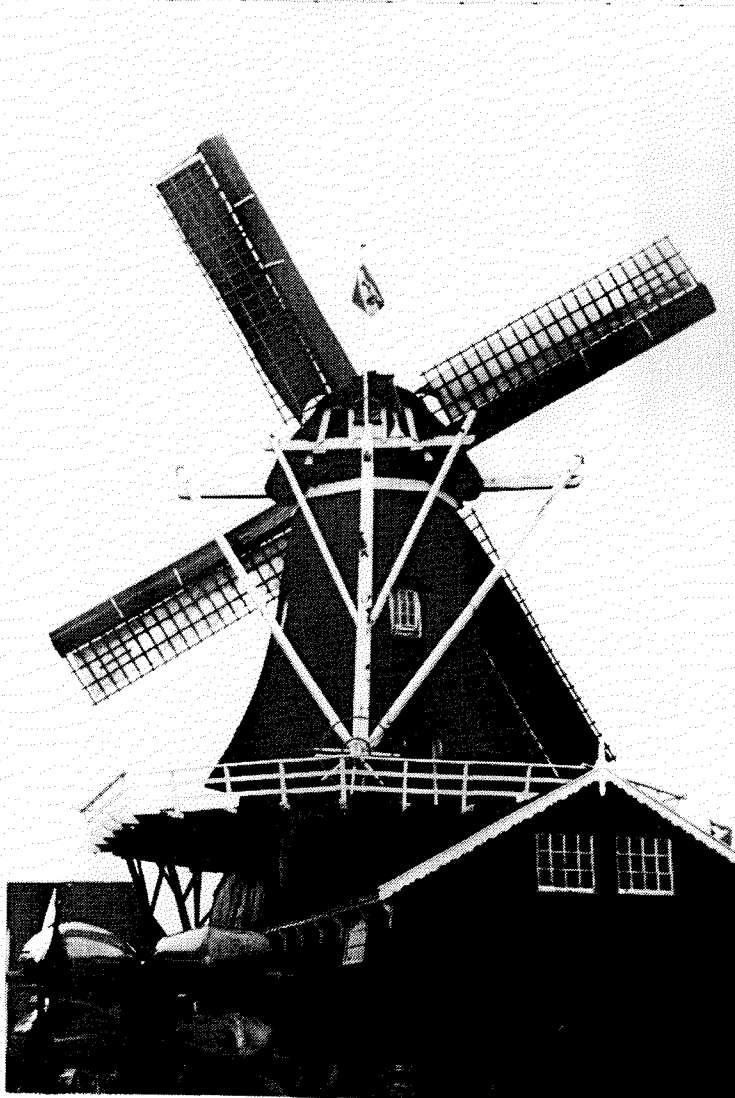
Afbeelding 25. Houtzaagmolen van het type bovenkruier: De Jager te Woudsend.
