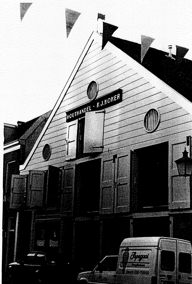
Afbeelding 39: De droogloods van de firma R.J. Koker te Utrecht. De loods wordt nu als atelier gebruikt
