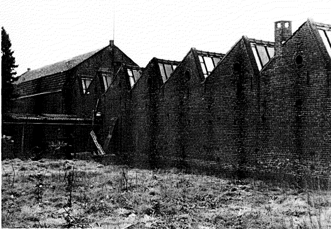
Afbeelding 9: De fabriekshal van de stoelen- en meubelfabriek v/h Ch. Teurlincx & Meyers te Oirschot. Dit is een goed voorbeeld van een gebouw met shed-daken
