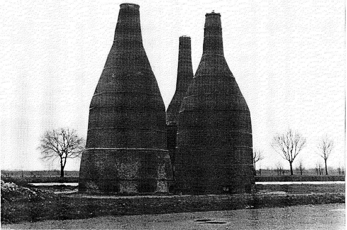
afb. 1 De schachtovens van de voormalige schelpkalkbranderij in Meppel. Zij zullen worden betrokken bij de bouw van een restaurant, waarbij één oven een museale functie krijgt en de overige twee ovens integreren in het restaurantgebouw.
