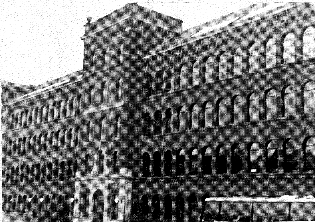
Boas, Nieuwe Uilenburgstraat, een voor-aanzicht. In het midden bevond zich de aandrijving, in de linker en rechtervleugel bovonden zich de slijpmolens
