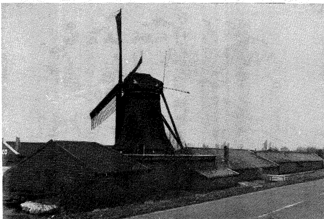
Afbeelding 17. Papierwindmolen "De Schoolmeester" in Westzaan. Links de lompenshuur, rechts de droogschuur met ventilatieluiken.
