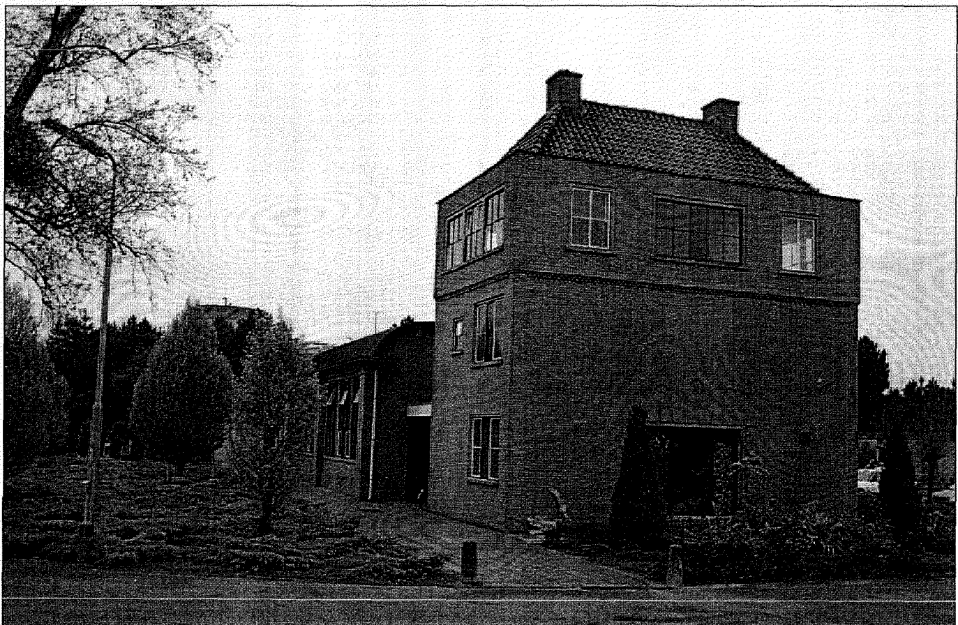
Foto 13: De voorkant van het bedrijfsgebouw op de zuiveringsinrichting van Enschede-West (Foto: N. Groeneveld).
