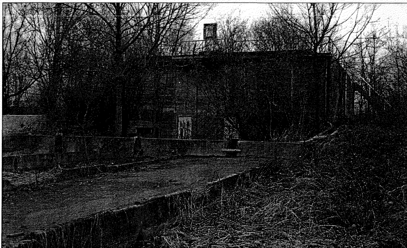
Foto 3: Imhofftank in Zaltbommel uit 1942. Op de voorgrond de niet meer in gebruik zijnde slibdroogbedden met de toestroomgoten (Foto: N. Groeneveld).
