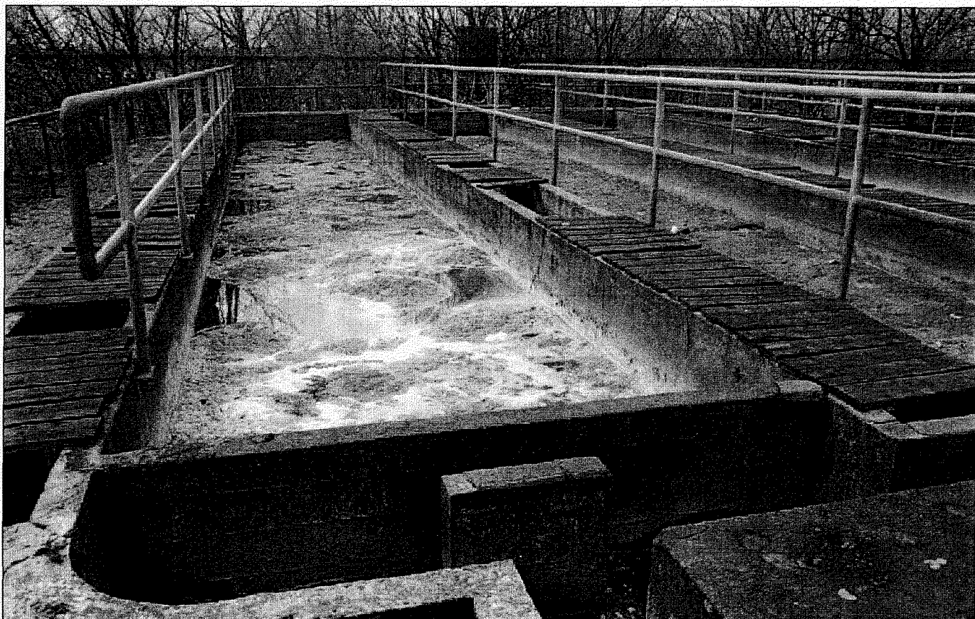
Foto 4: Imhofftank in Zaltbommel uit 1942. Bovenaanzicht met de bezinksleuven. De sleuven waar het biogas kan ontsnappen zijn afgedekt met hout. Op de voorgrond de invoergoten (Foto: N. Groeneveld).
