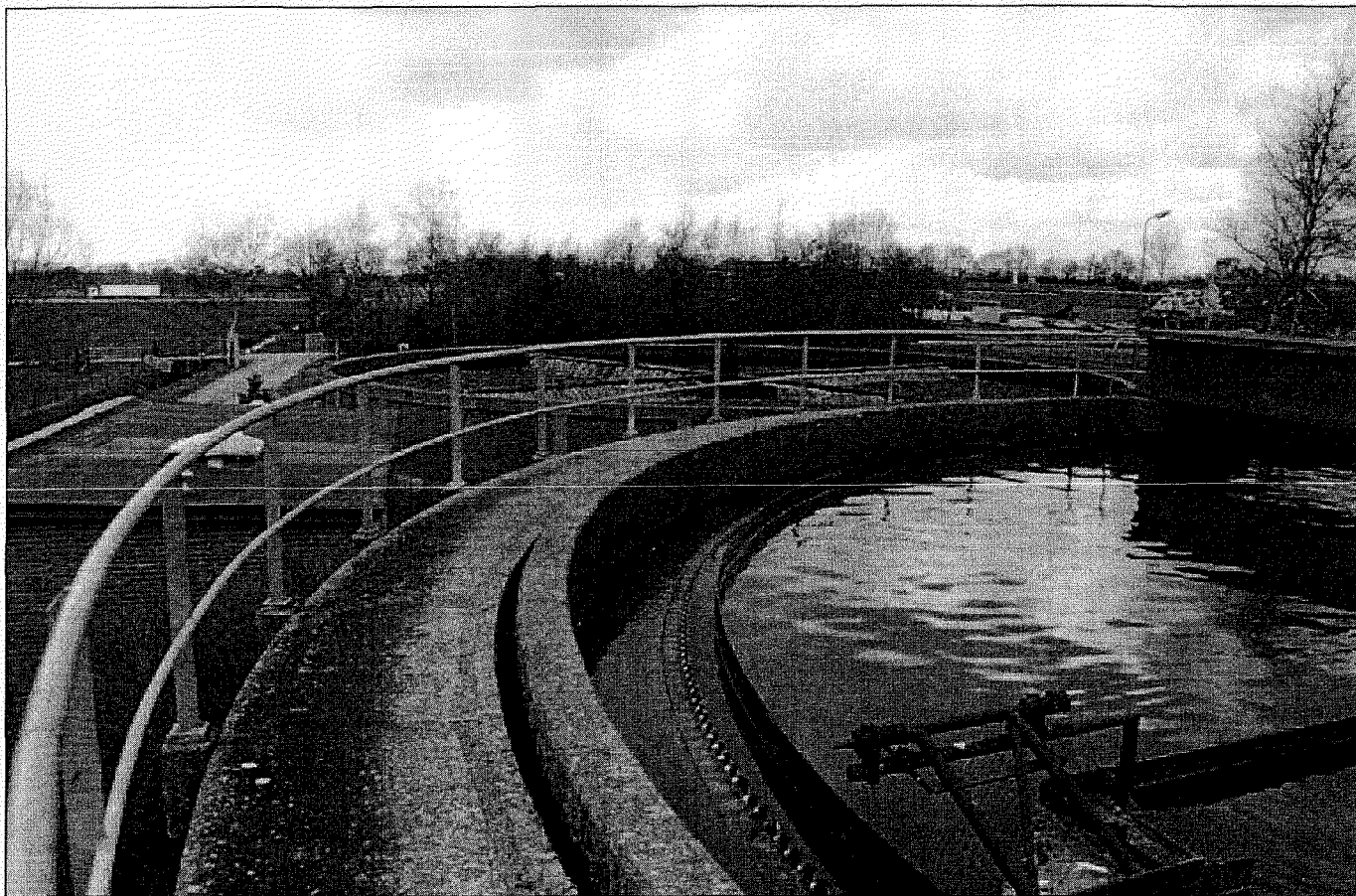
Foto 9: De Clarigester in Lunteren werd in 1967 in bedrijf gesteld. Op de achtergrond is het oxydatiebed van de zuivering te zien. Links op de foto het gebouw waar de chemicaliën worden gedoseerd. Deze inrichting zal eind 1994 gesloten worden (Foto: N. Groeneveld).
