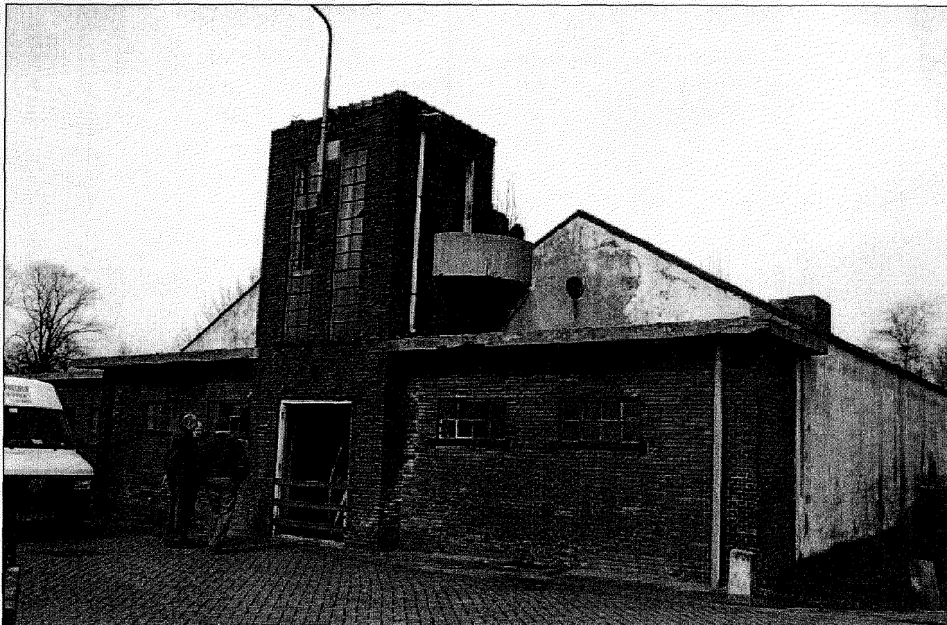
Foto 19: De oude chemische slibbehandelingsruimtes, gebouwd in de jaren dertig, op de zuiveringsinrichting Tilburg-Oost (Foto: N. Groeneveld).
