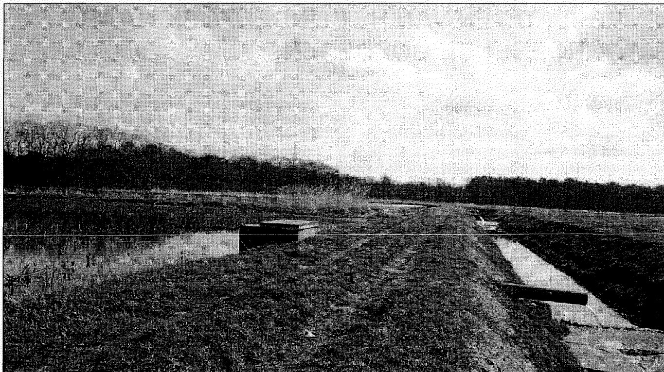
Foto 2: De vloeivelden van Loon op Zand die in de jaren dertig in gebruik zijn genomen. Nadat het water via het aanvoer kanaal op de velden is gekomen stroomt het aan de andere zijde 'gezuiverd' in een sloot (Foto: N. Groeneveld).
