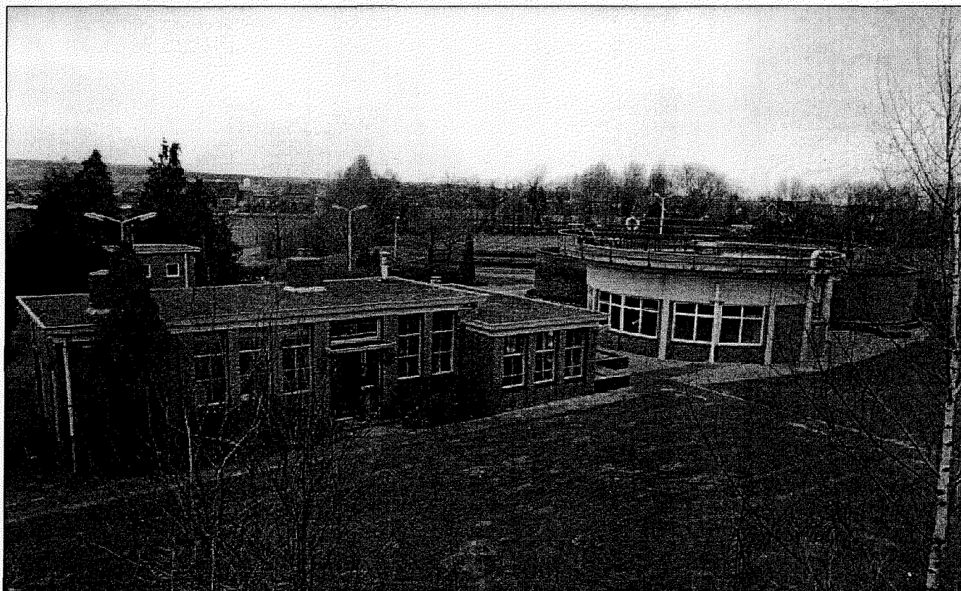
Foto 11: De waterzuiveringsinrichting Groesbeek-Noord gebouwd in 1956 en van het type oxydatiebed. Links op de foto het gemaal met de opvoerpompen. Rechts de voorbezinktank met daarachter-nog net te zien- de oxydatiebedden (Foto: N. Groeneveld).
