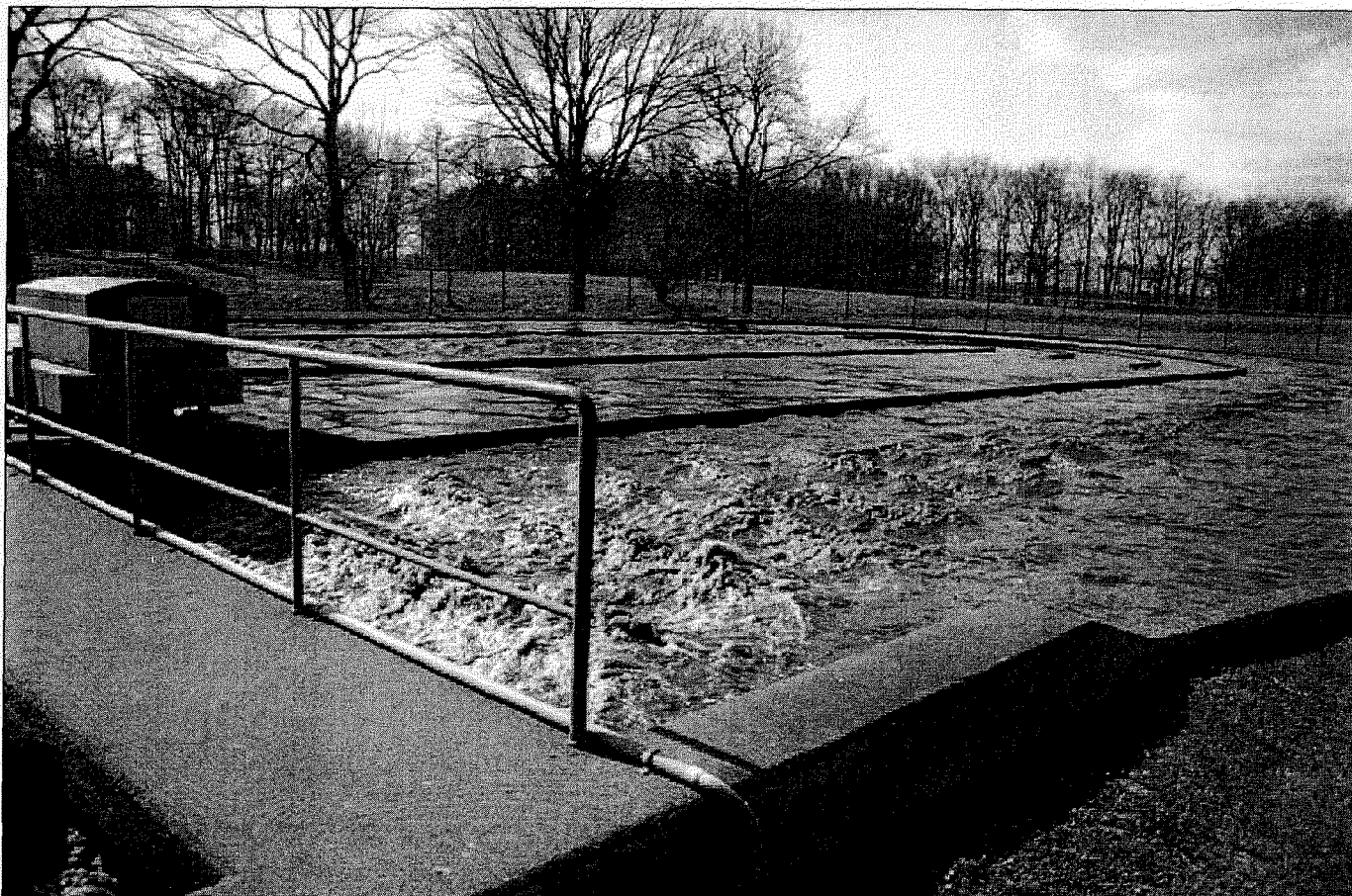
Foto 16: De zuiveringsinrichting (type oxydatiesloot) van Scherpenzeel is een voorloper van de Carrousel. Hier vindt nog beluchting plaats met borstels, bij de Carrousel door puntbeluchters (Foto: N. Groeneveld).
