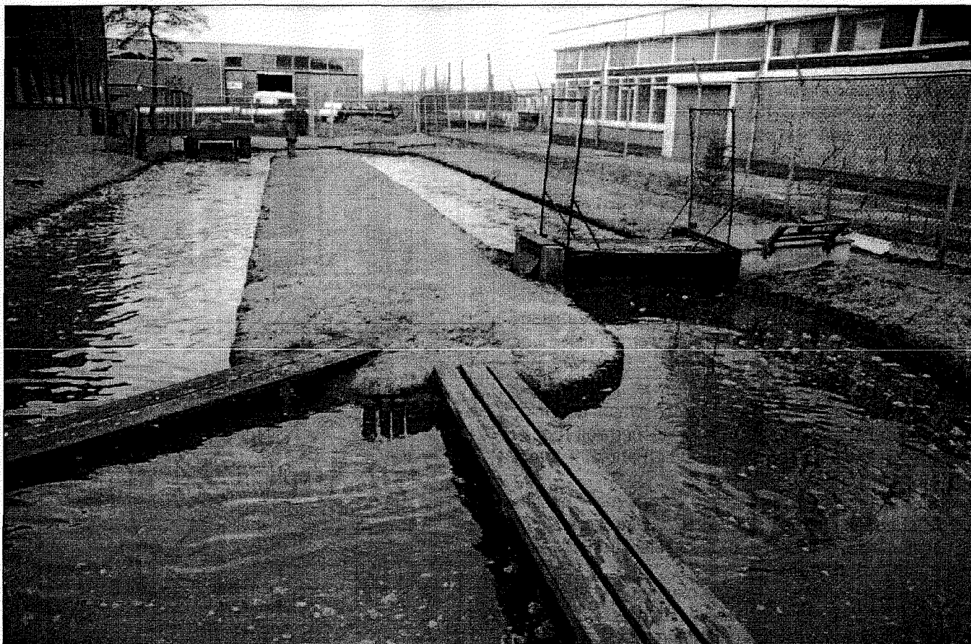
Foto 14: Afvalwaterzuiveringsinrichting Voorschoten . Gebouwd in 1954 als proefinstallatie. Het betreft hier de allereerste oxydatiesloot. Op de voorgrond de originele Kessener beluchtingsborstels. Op de achtergrond de later bijgebouwde beluchtingsborstel (Foto: N. Groeneveld).
