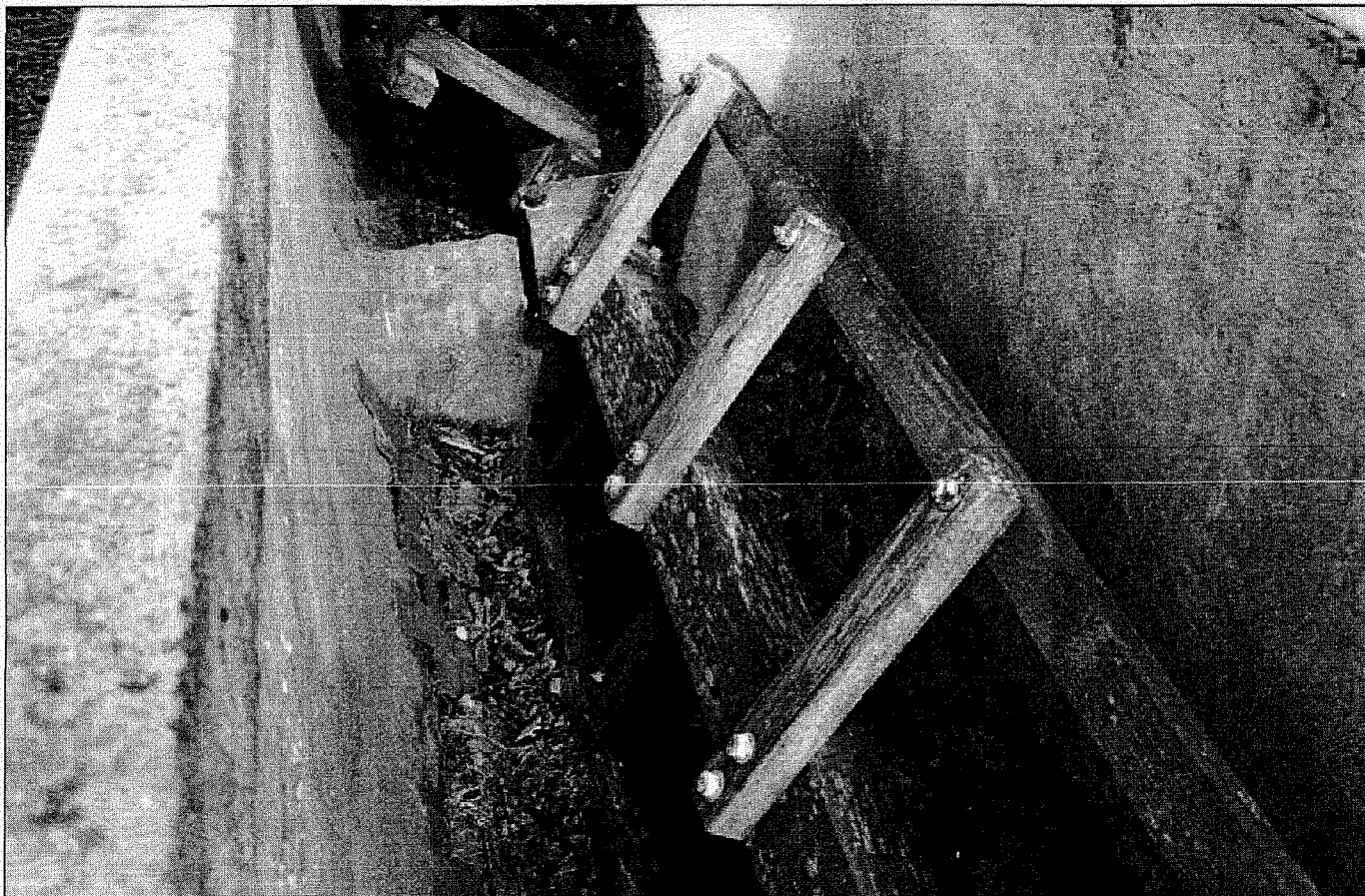
Foto 20: Detailopname van de roerwerken in het gebouw van de chemische slibbehandeling in Tilburg-Oost (± 1930). Zowel de roeders als de lagering zijn van hout! (Foto: N. Groeneveld).
