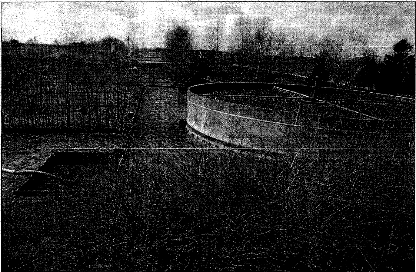
Foto 6: Het oxydatiebed van de zuiveringsinrichting Harskamp (1959). Links zijn de slibdroogbedden te zien met betonnen kantelafsluiters (Foto: N. Groeneveld).
