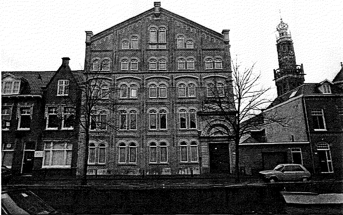
Afb.29: De broodfabriek aan de Bakenessegracht in Haarlem. Het gebouw is het grootste gebouw in z'n omgeving en steekt boven de overige panden aan de gracht uit.
