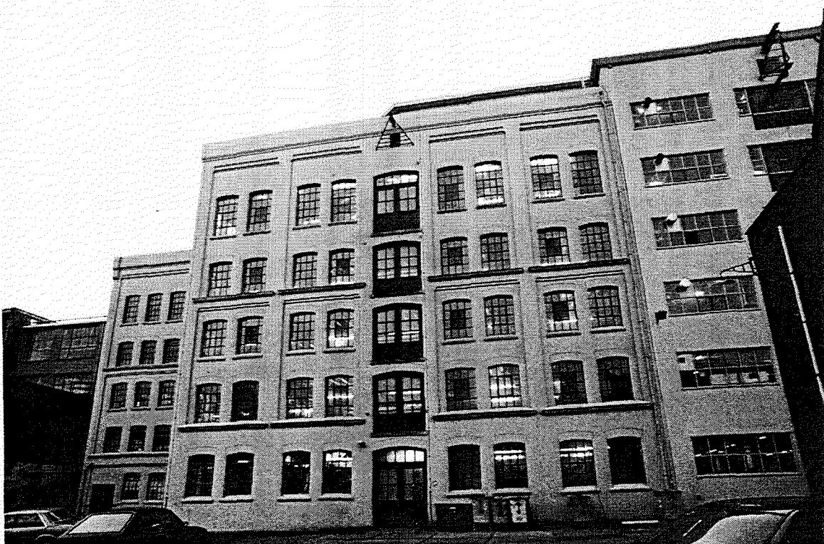
Afb.34: De achtergevel van rijstpellerij Lassie is in oorspronkelijke staat gerenoveerd.
