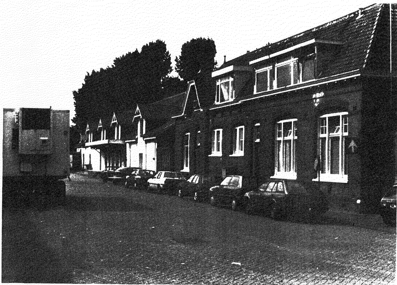
Afbeelding 25. Openbaar slachthuis van Haarlem. Het slachthuis werd in 1907 geopend en is een mooi voorbeeld van het gemengd Frans-Duitse type. Op de voorgrond staan de kantine en ruimte van de keurmeesters, daarachter staan de runderstallen die nu zijn omgebouwd tot gekoelde opslagruimte voor de gebruikers van het slachthuis.
