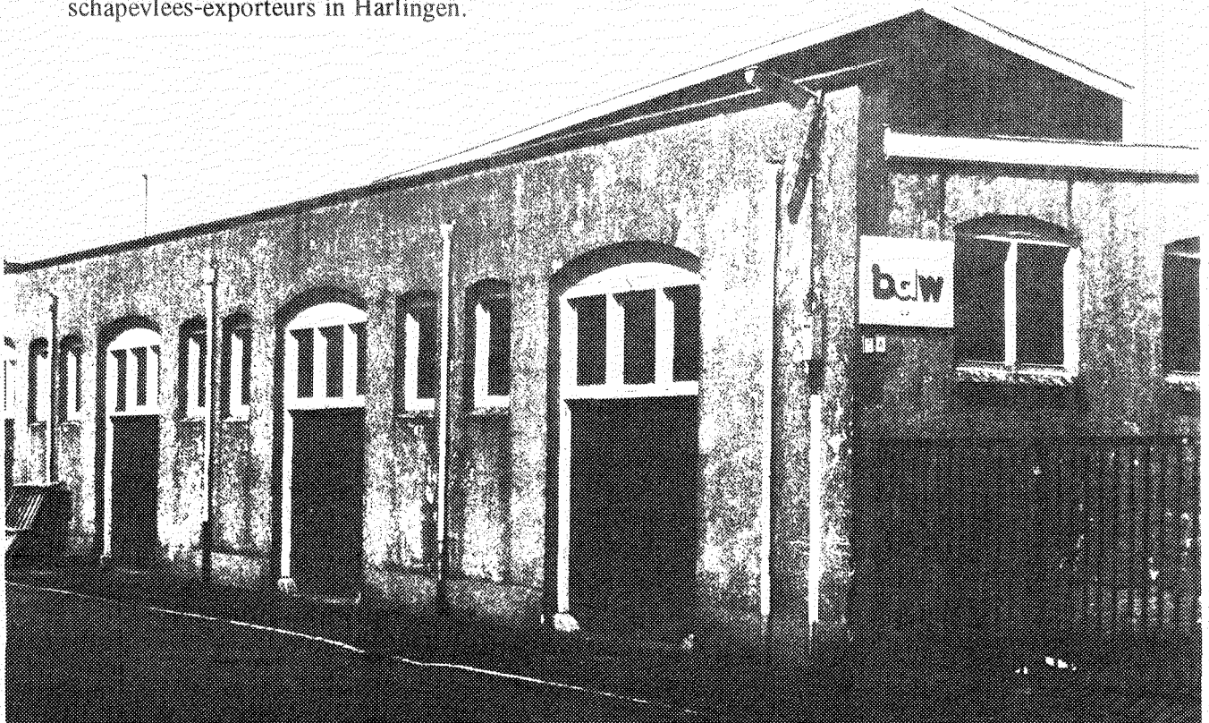
Afbeelding 5. In deze gebouwen aan de haven van Harlingen slachtten slachters schapen voor de Engelse markt. Er bestond aan het begin van deze eeuw een directe bootverbinding met onder andere Newcastle en Hull.
