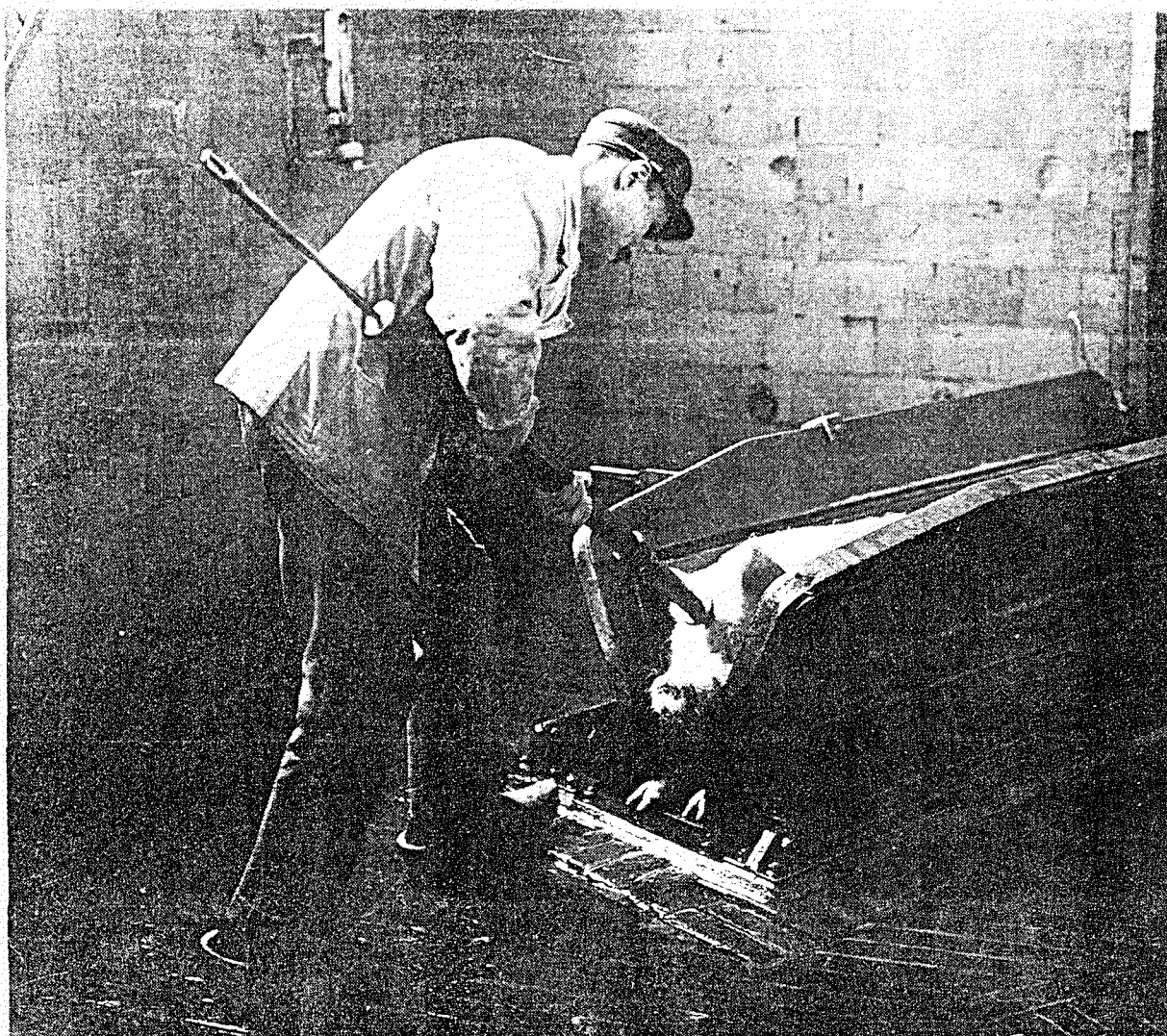
Afbeelding 11. Voordat de slachter het dier slachte, verdoofde hij het eerst. Hier gebeurd dat met een percuteur van Pilet. Terwijl het varken ingeklemd was in een val, dreef de slachter met een sterke spiraalveer een pen in de hersenen van het varken, waardoor het bewusteloos raakte.
