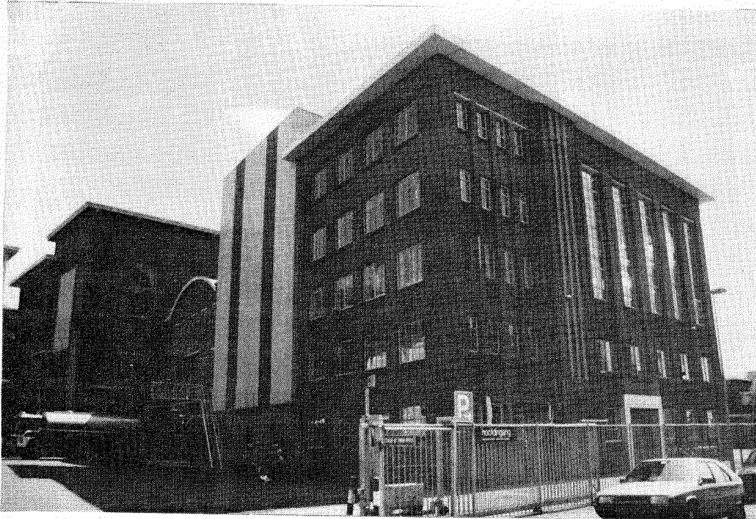
Afbeelding 6. De coöperatieve melkproduktenfabriek de "Ommelanden" te Groningen uit 1924 functioneert nog steeds als zodanig. De tanks hebben hun intrede gedaan in een schitterend tanklokaal met een halfronde overkapping. Elementen uit het ontstaan van de fabriek zijn soms nog aanwezig. De blikfabriek staat leeg, de verstuivingstoren is verdwenen maar het hoge gebouw waar deze toren in stond is nog zichtbaar. Het laboratorium is nog terug te vinden op de plek waar zich nu het kantoor bevindt.
