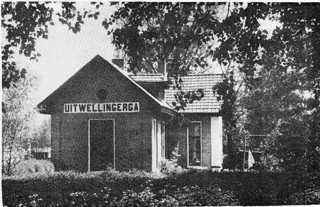
Afbeelding 4. Het tramhuisje behorend bij de coöperatieve stoomzuivelfabriek 'De Westerbrugsloot' (1903-1965) te Uitwellingerga. Het tramhuisje duidt op de aanwezigheid van een voormalig spoor voor de aanvoer van steenkool.
