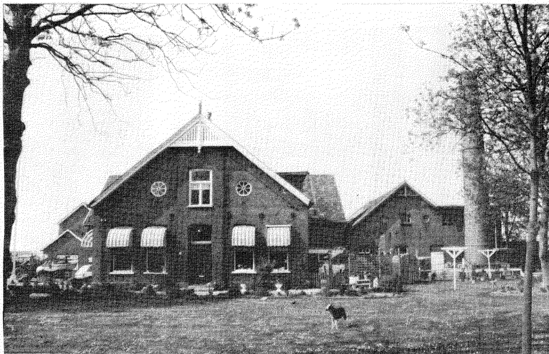
Afbeelding 1. De coöperatieve stoomzuivelfabriek "Warns e.o." was boter- en kaasfabriek in de jaren 1899-1965. In de voorgevel bevinden zich twee kleine roosvensters. Aan de achterzijde grenst de fabriek aan het water voor de aanvoer van melk en brandstof. Deze zuivelfabriek is herbestemd als watersportbedrijf en zeilmakerij, zoals veel voormalige stoomzuivelfabrieken in Friesland. Uit
