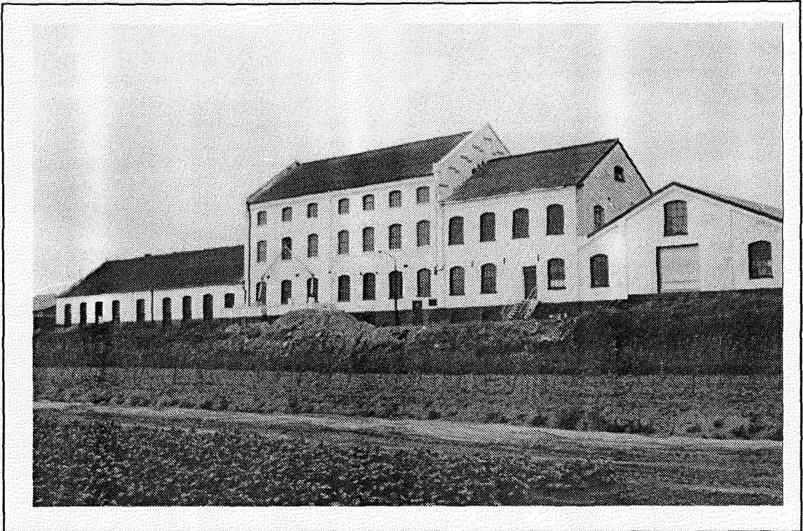
Afbeelding 20 Bij St. Antoine in Oud-Gastel geven de gietijzeren rondboogvensters, de houten kapconstructie, de troggewelven en de open binnenruimten een redelijke indruk van een vroege bietsuikerfabriek.
