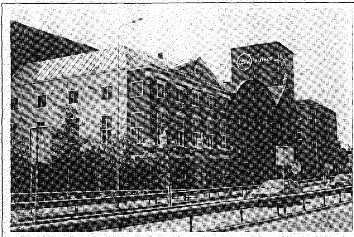
Afbeelding 22 Het 17de eeuwse Gemeenlandshuis werd tot 1950 gebruikt voor het produktieproces van Holland te Halfweg. De verdampingsketels stonden hier opgesteld. Dit gedeelte is reeds tot monument verklaard.
