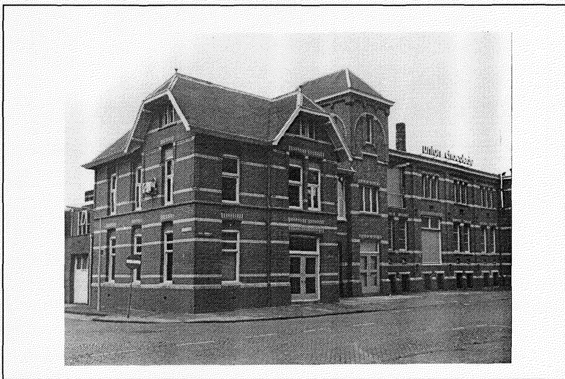
Afbeelding 27 Opvallend is de perfecte staat waarin het pand van Chocoladefabriek Union in Haarlem verkeert. Een bewijs dat binnen deze subbranche een pand uit 1902 nog steeds voldoet.
