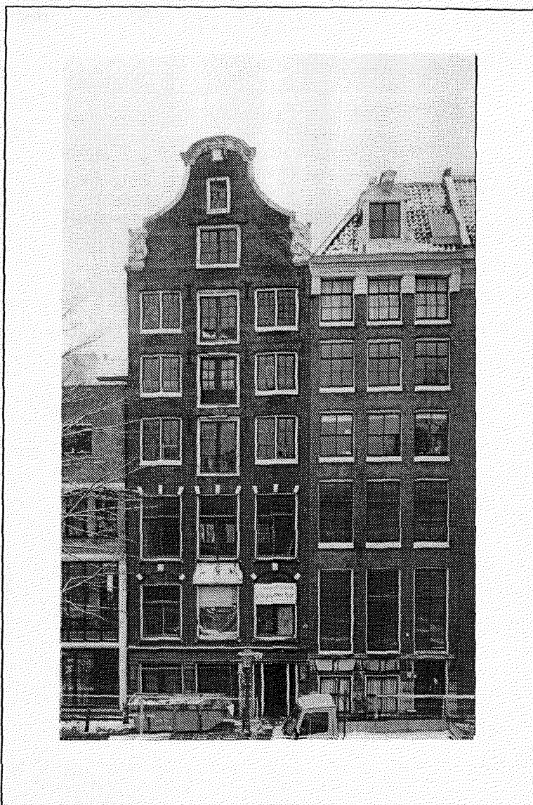
Afbeelding 18 Tot 1865 was in dit pand raffinaderij De Saayer gevestigd. De gevelsteen is daarvoor de enige aanwijzing. Het is een L-vormig gebouw met zes gebruikslagen, een zolder en een klokgevel.
