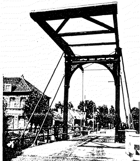
Ophaalbrug van het Hollandse type, met hameipoort. De brug over de Hollandsche IJssel te Haastrecht, 1883.
