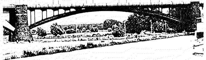
De aanbrug van de brug over de Waal te Nijmegen: zuivere boogbrug met een volwandige boog en hooggelegen rijvloer.
