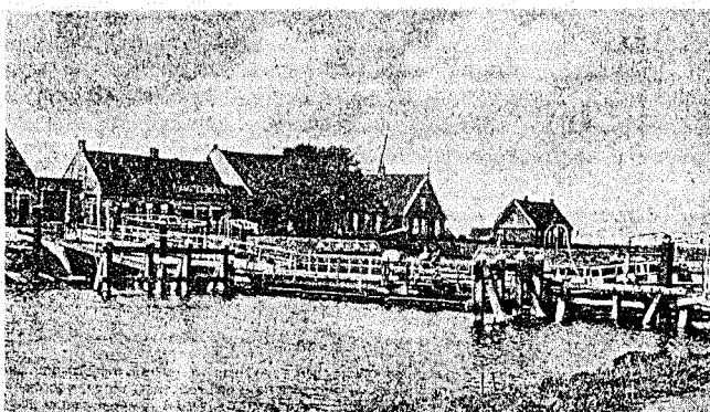
De voormalige vlotbrug bij De Kooy (Den Helder).
