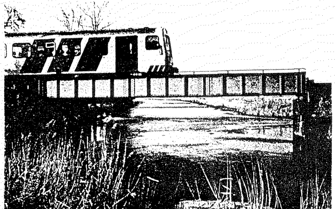
Spoorbrug met samengestelde liggers.
