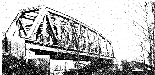
Enkelvoudig vakwerk met parabolisch gebogen bovenrand, schuine beëindiging, verticalen, vallende en stijgende diagonalen.
