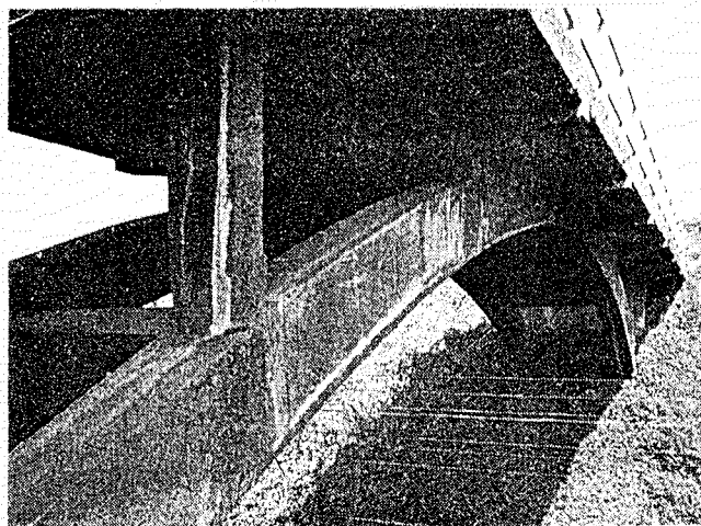
De boogribbenbrug bij Wijlre over de spoorweg Maastricht-Aken, 1906.
