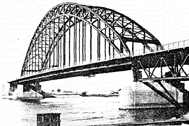
Brug voor gewoon verkeer over de Noord te Hendrik-Ido-Ambacht: boogbrug met trekband en bij de oplegging samenkomende boogranden.
