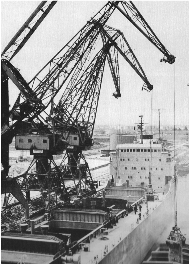
Drie kranen op nieuwe Terminal aan de Laurenshaven. Overslag van fosfaat boord/boord.
