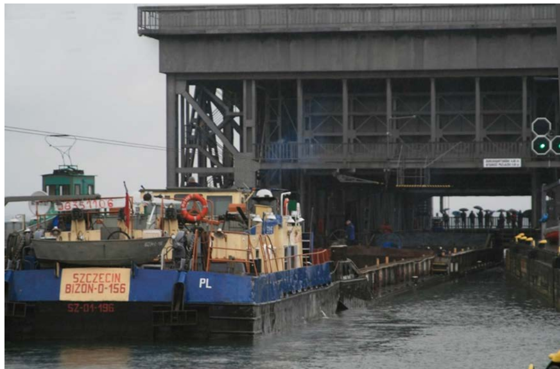
Een duwcombinatie vaart, met behulp van een elektrisch locomotiefje, de oude scheepslift in. (Foto: Jur Kingma, 25 mei 2013)
