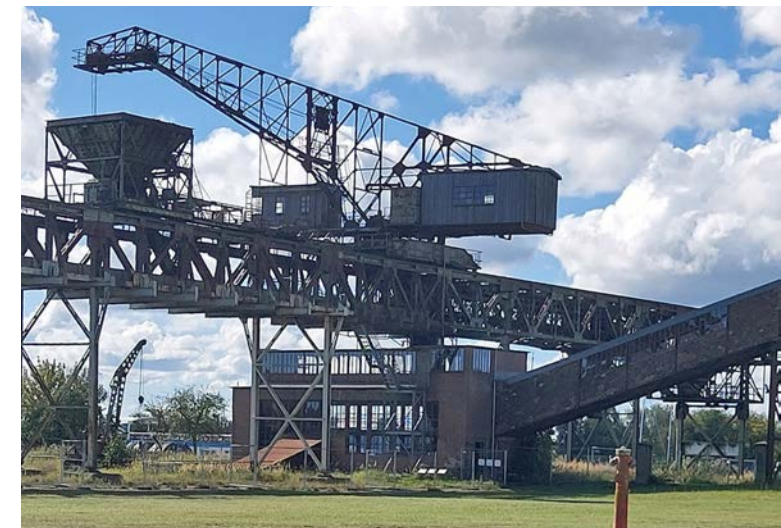
Kraanbaan kolenlosinstallatie met MAN kraan Peenemünde. (Foto: Jur Kingma, 22 september 2025)
