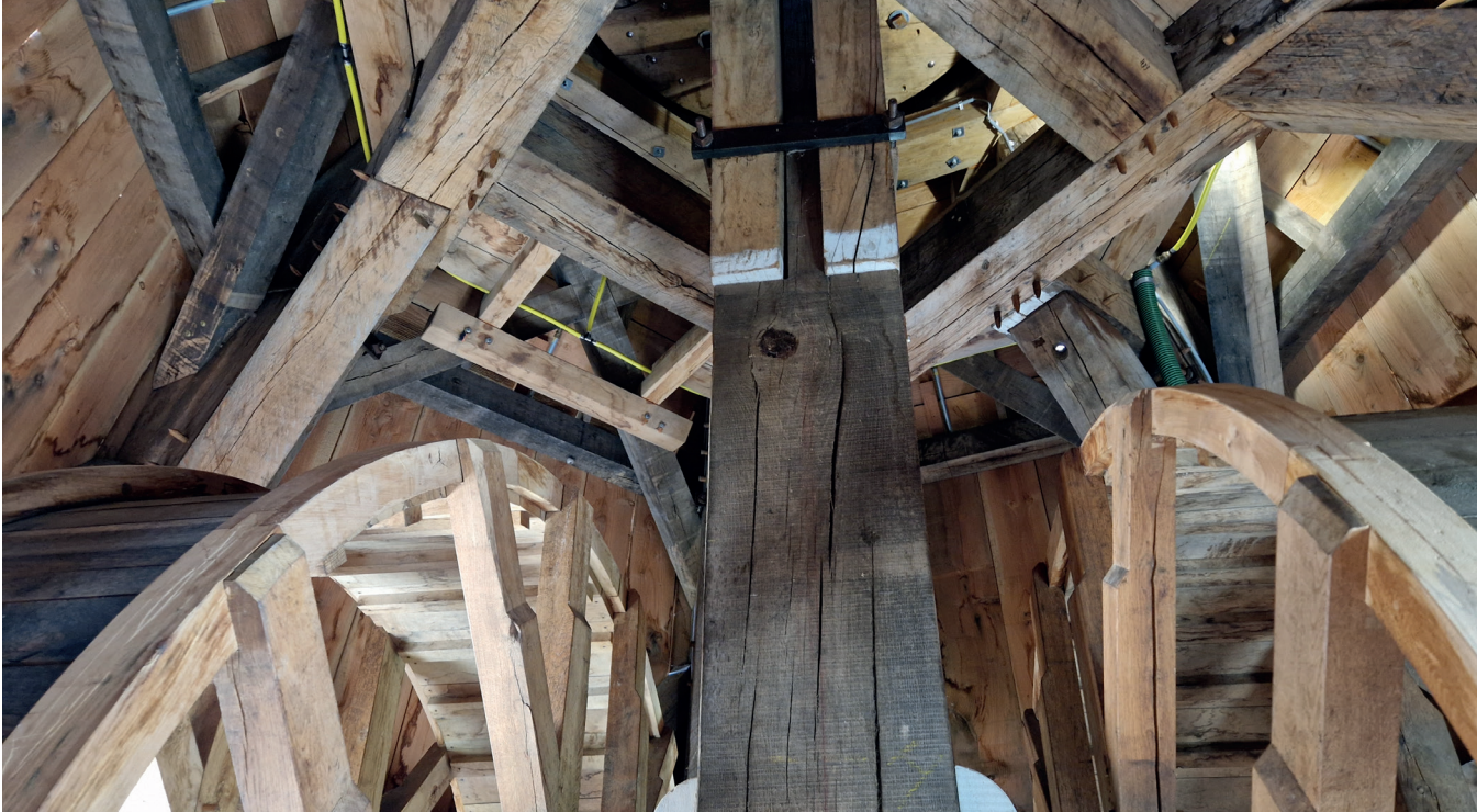
Ter weerszijden van de spil zijn de tredaderen opgesteld, waarmee de kraan met menskracht wordt aangedreven. Onder een detal. 19-06-2025 Foto's: Helmig Kleerebezem
