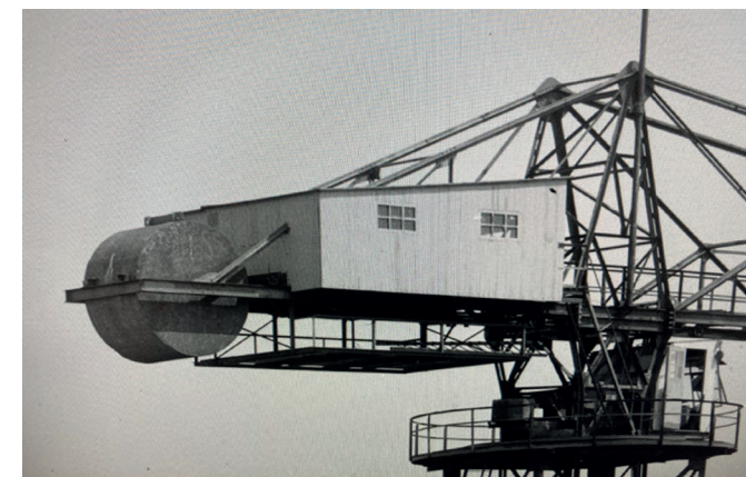
Het contragewicht zit nog op zijn plaats.
