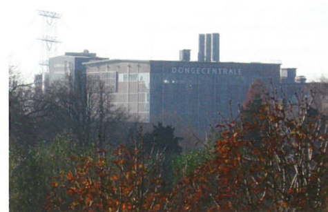
Geertruidenberg. De Dongecentrale uit 1919, de eerste Brabantse elektriciteitscentrale. De installatie is vervangen door de nabijgelegen Amercentrale. Foto Michiel1972 wikimedia
