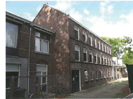
Utrecht. Het hoofdgebouw van de monumentale wasserij Aurora. Foto Marcel Overbeek
