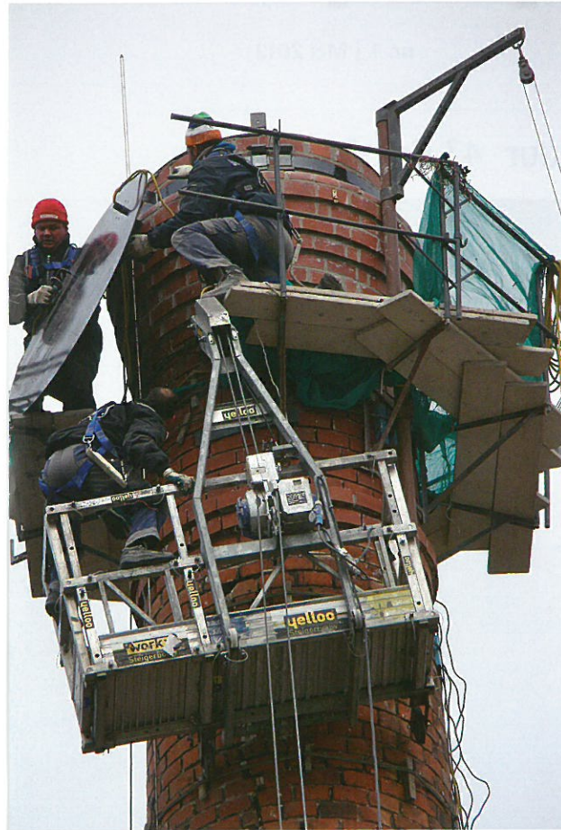
Groningen. De laatst overgebleven fabrieksschoorsteen aan het Boterdiep stond dit voorjaar in de steigers. Foto's Bart Kempinga
