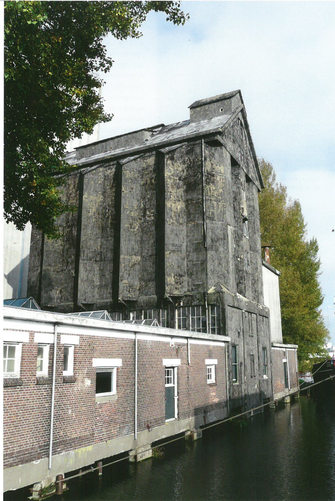
Deventer. De Zwarte Silo in het Havenkwartier, wachtend op de restauratie. Foto Marcel Overbeek
