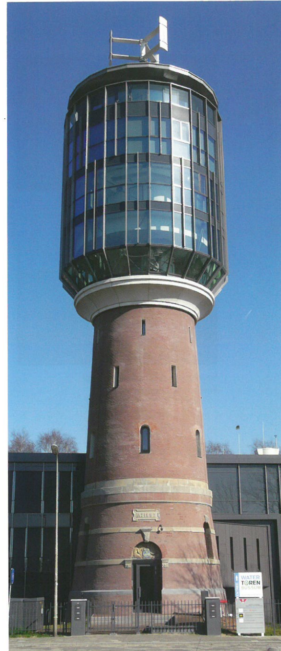
Bussum. De duurzame en energiezuinige watertoren. Foto Marcel Overbeek
