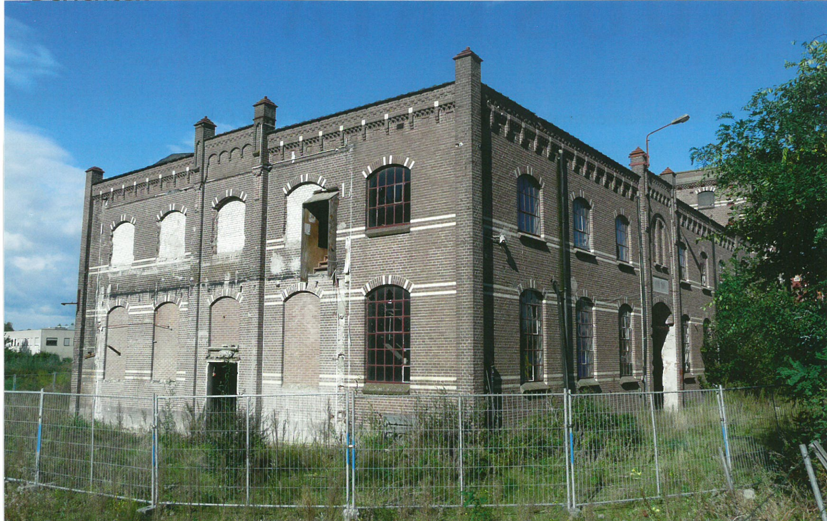
Utrecht. Restant van de afgebrande Cereolfabriek. Foto Marcel Overbeek
