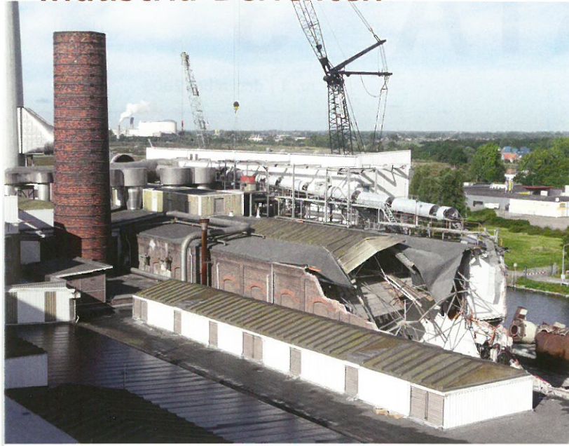
Groningen, suikerfabriek van Heemskerkstraat tijdens de sloop. Foto Marcel Overbeek
