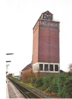
Wehl. Graansilo van de maalderij. Foto Marcel Overbeek
