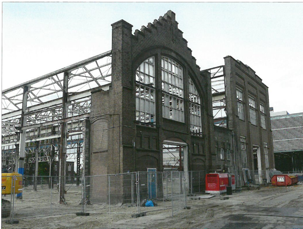
Het onttakelde Stork-'Hijschgebouw', november 2008. Foto Marcel Overbeek
