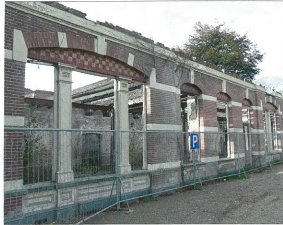
Het oudste deel van de textiel fabriek Driessen, aangetast door brand. Foto Marcel Overbeek, oktober 2008.
