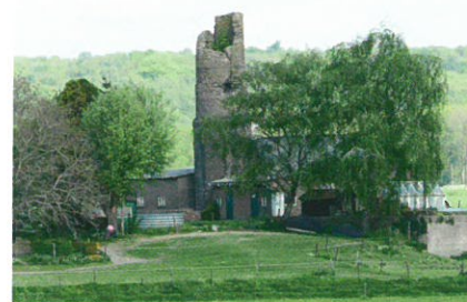
Restant schoorsteen, Driel Foto Marcel Overbeek
