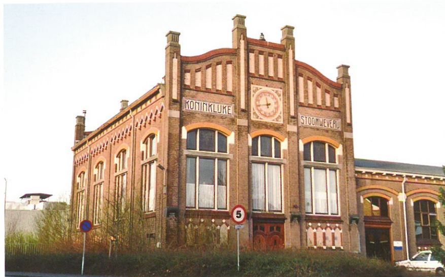
Nijverdalse Turbinehal textielfabriek Ten Cate Foto Marcel Overbeek.
