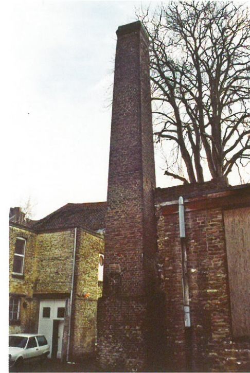
De vierkant gemetselde fabrieksschoorsteen van de firma Bauduin
