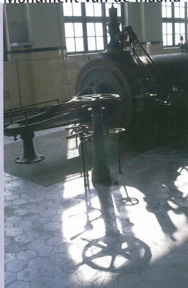
Oisterwijk stoommachine KVL Oisterwijk. Foto Gerhard de Wit
