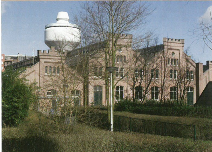
Amsterdam Westerpark: voormalig waterbedrijf. Foto Pim van Gelder
