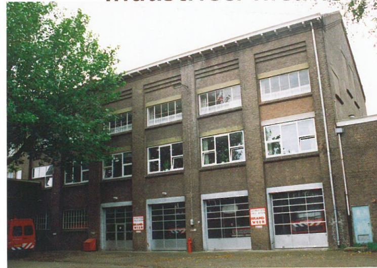
Meppel: De voormalige gasfabriek Foto Marcel Overbeek
