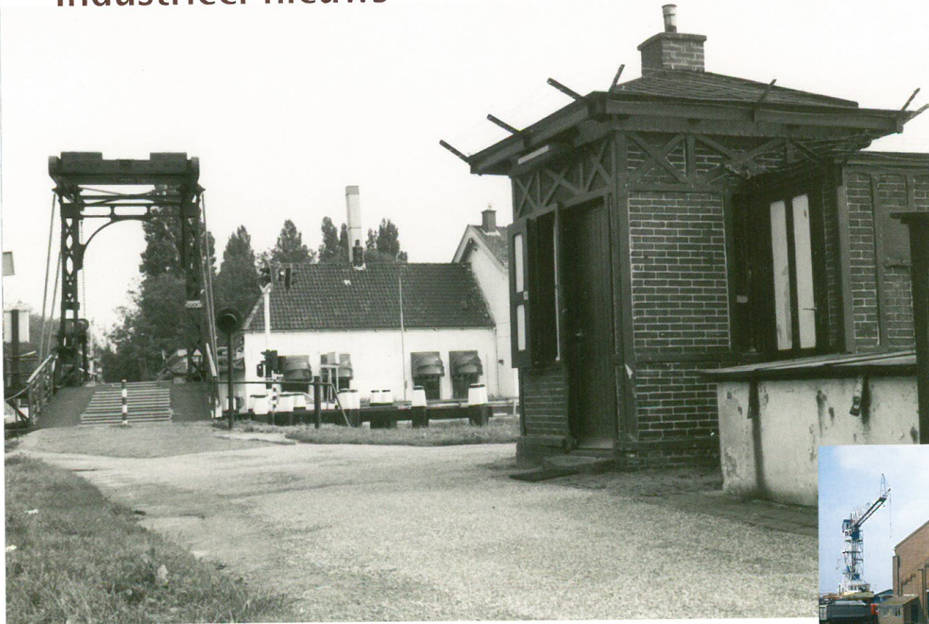
Voorburg: Brugwachtershuisje bij Westeindebrug. Foto Marcel Overbeek
