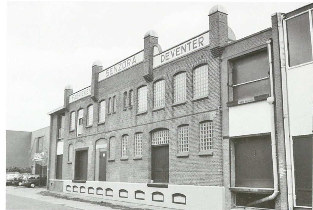
Deventer, fabrieksgebouwen Sensora (foto Marcel Overbeek)
