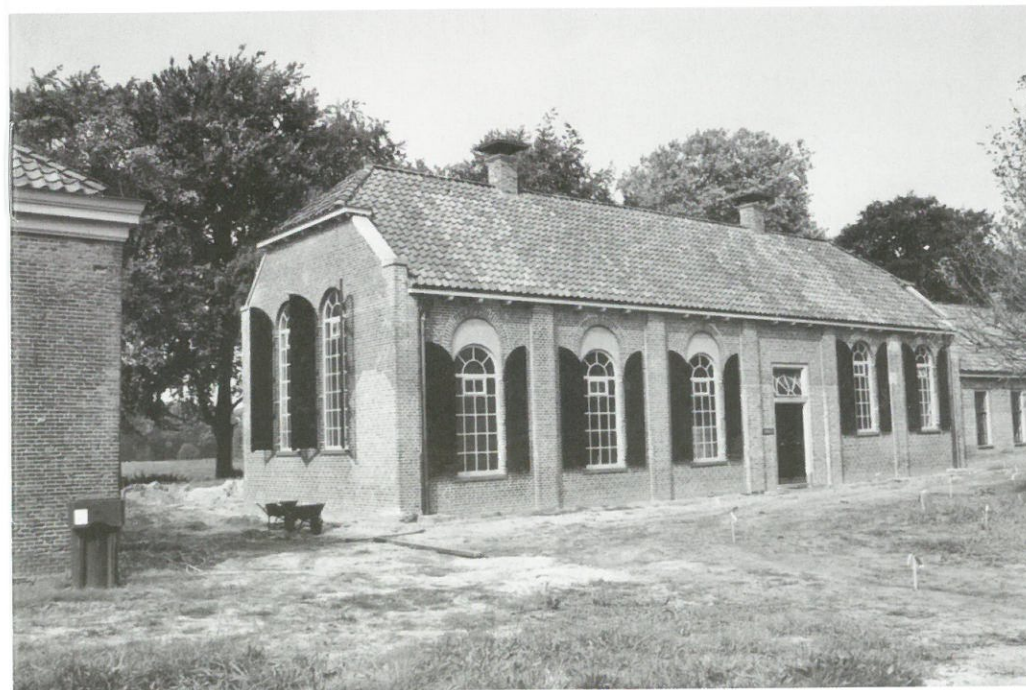
Veenhuizen, voormalige stoomspinnerij na restauratie (foto Marcel Overbeek)
