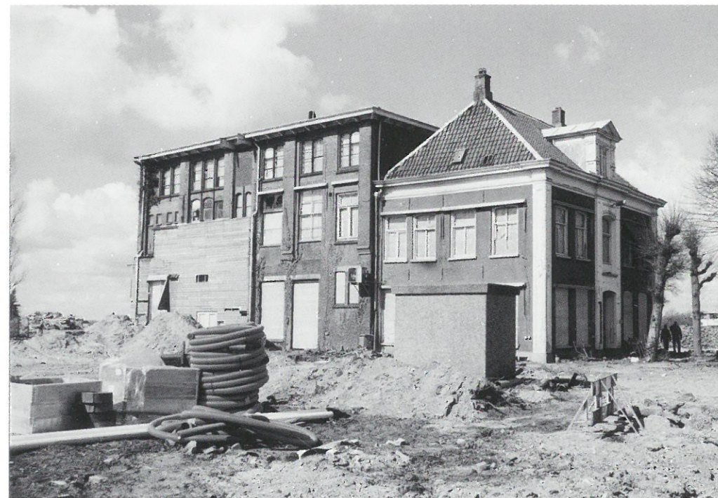
Kampen, restant Berkfabriek (foto Marcel Overbeek)
