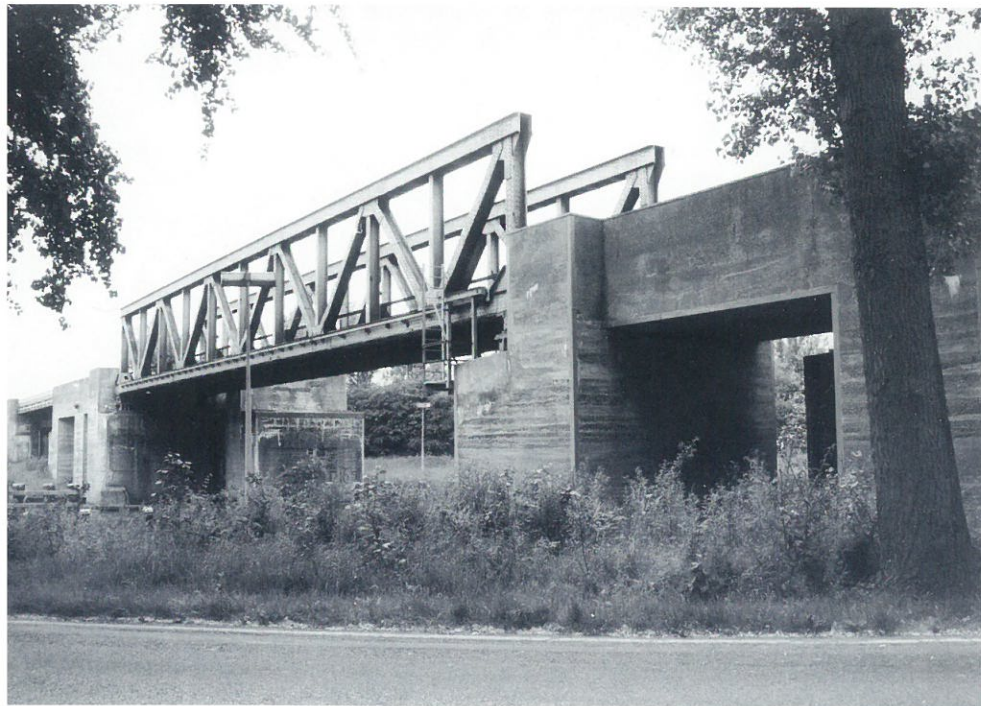
Sporbrug Van Starckenborghkanaal, Groningen (foto Marcel Overbeek)
