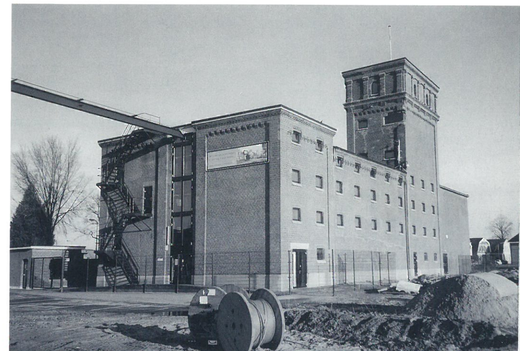
Enschede: balengebouw Roombeek (foto Marcel Overbeek)
