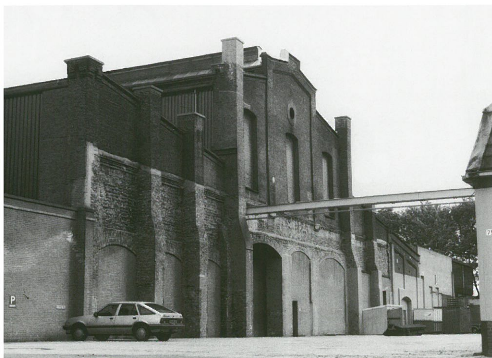
Hengelo: gieterijhal Stork (foto Marcel Overbeek)
