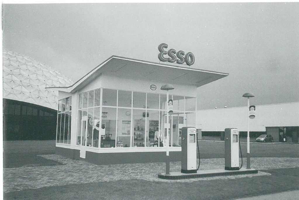
Raamsdonksveer: benzinestation (foto Marcel Overbeek)
