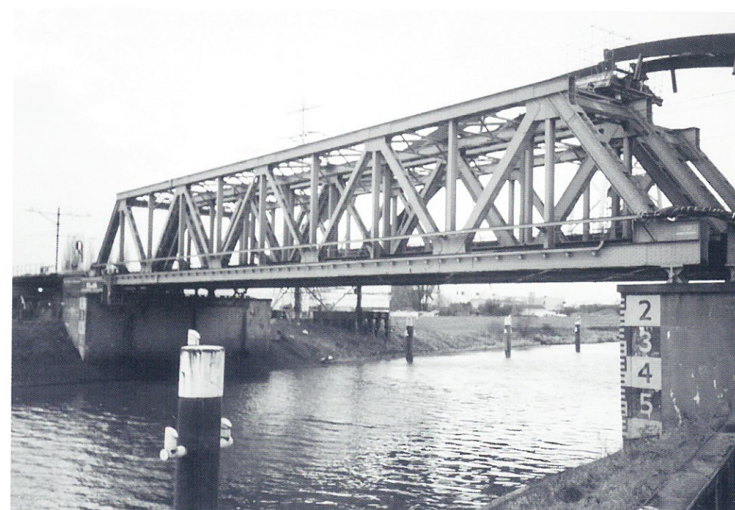
Eefde, spoorbrug Twentekanaal (foto Marcel Overbeek)
