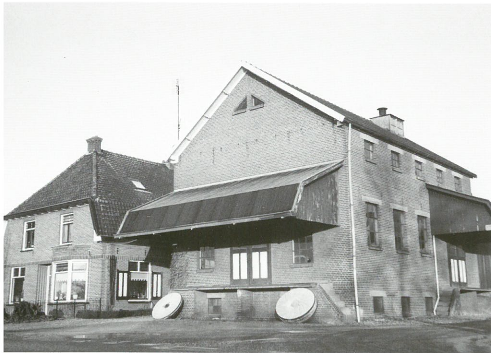
Oene, graanmaalterij met woonhuis (foto Marcel Overbeek)
