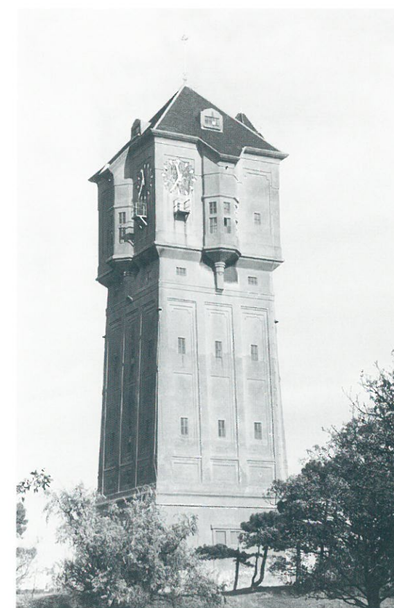
Watertoren in IJmuiden (foto Marcel Overbeek)
