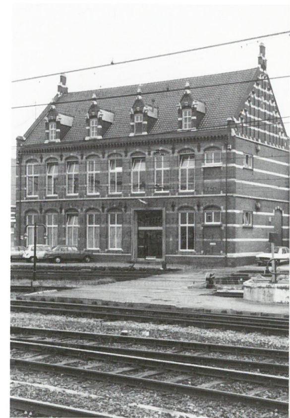
Arnhem, stationspostkantoor (foto Marcel Overbeek)
