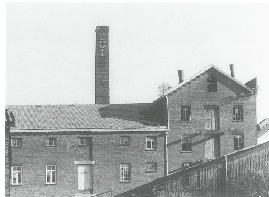
Roermond: voormalige meelfabriek, later chemische fabriek 'ECI' (1870).
