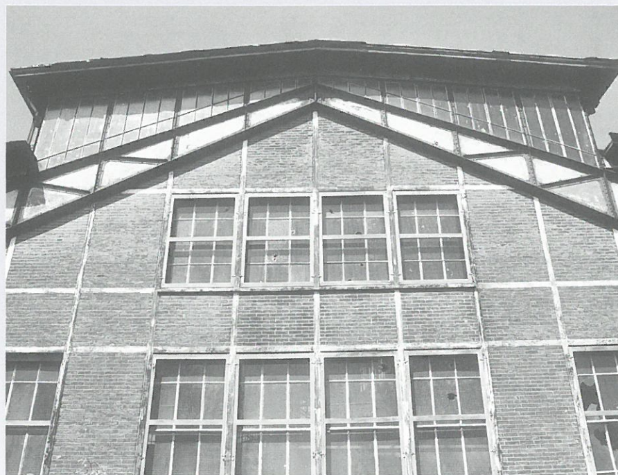
Locomotiefloods Weert (1913), ontwerp G.W. van Heukelom
