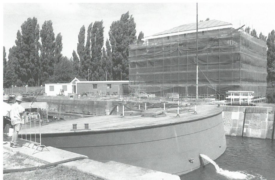
Droogdok met herbouw pompgebouw (2001)
