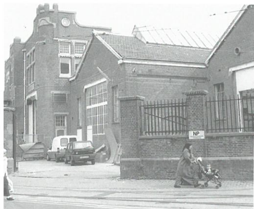
Amsterdam: tramremise Bellamystraat.
