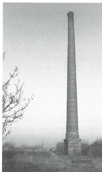
Olst: schoorsteen voormalige steenfabriek 'Fortmond'.
