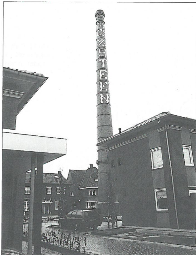
Gilze: schoorsteen leerfabriek "Gebr. Van der Steen"
