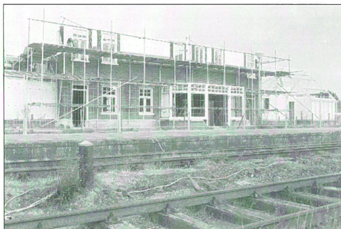
Stadskanaal: station STAR in aanbouw.
