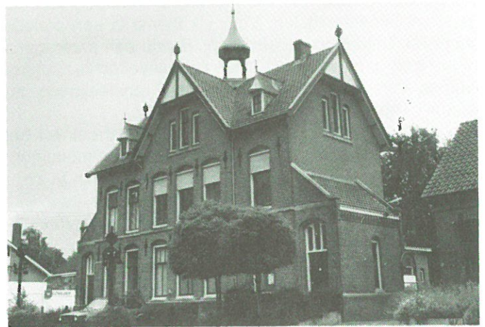
Twello: voormalig postkantoor.
