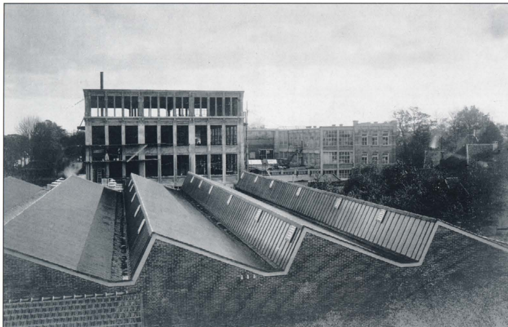
Het laatste deel van de spoelerij in aanbouw 1922.
