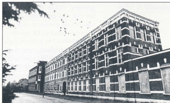
De verlaten Tricotfabriek aan de Wilhelminastraat.
