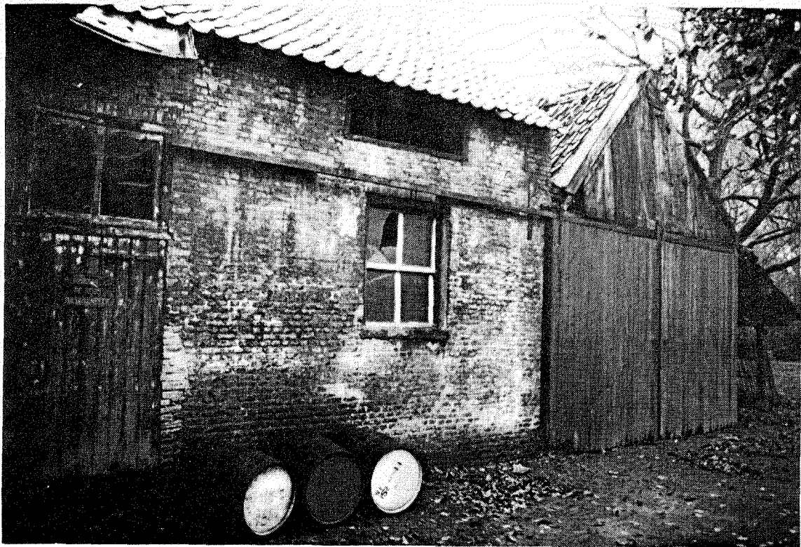
Afbeelding 16. Het brouwgedeelte van brouwerij De Roos te Hilvarenbeek. De opening pal onder de dakrand markeert de plaats waar koelschip opgesteld is. Het gebouw toont duidelijk de agrarische oorsprong van het bedrijf.
