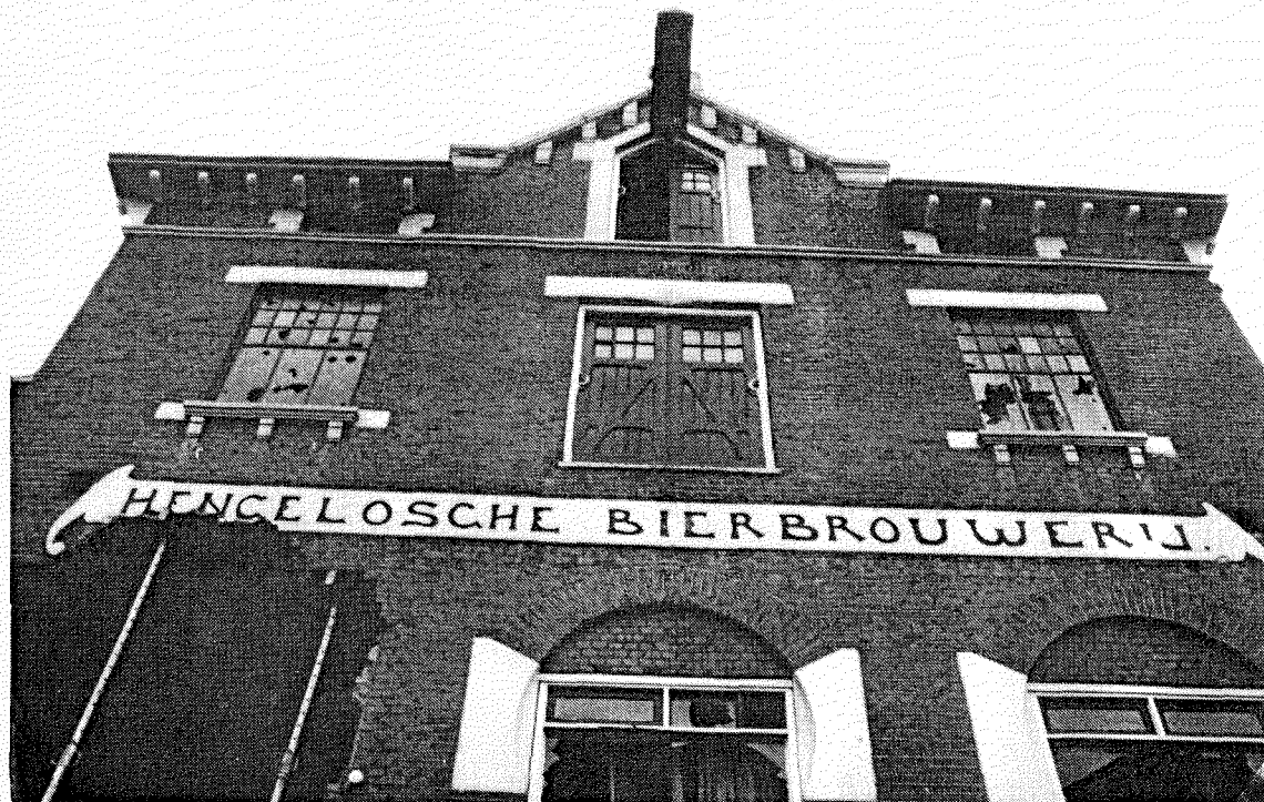
Afbeelding 24. De gebouwen van de in 1987 gesloten Hengelosche Bierbrouwerij vormen ondanks hun desolate toestand nog steeds een heldere illustratie van een vroeg-industriële bierbrouwerij. De brouwerij lag direct aan het Hengelose stationsemplacement. Het op de foto afgebeelde brouwhuis uit 1905 vertoont sporen van de Jugendstil. Het gat in de voorgevel ontstond toen het in het gebouw aanwezige ontgassingsapparaat verwijderd werd.
